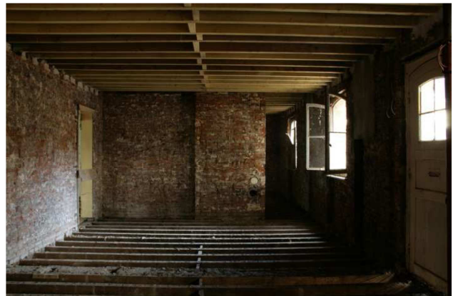
étage courant découloigné – plancher bois conservé
