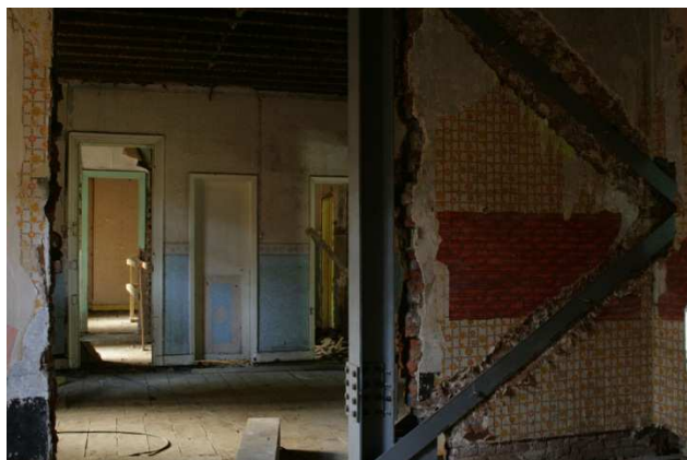
palée verticale toute hauteur insérée dans un refend en maçonnerie
