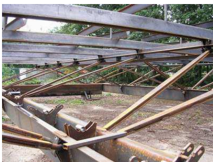
Détail d'assemblage - toile, baleines, arbalétriers et poutre Chéneau en tôle pliée
