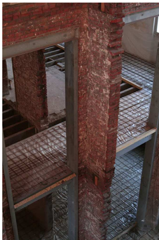
Membranes en béton allégé mince structurel
