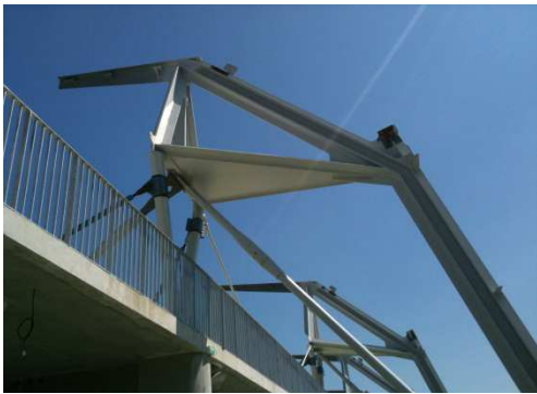
partie arrière support de poutre en porte à faux - début de montage – calculs Exe et modèle 3d MaP3
