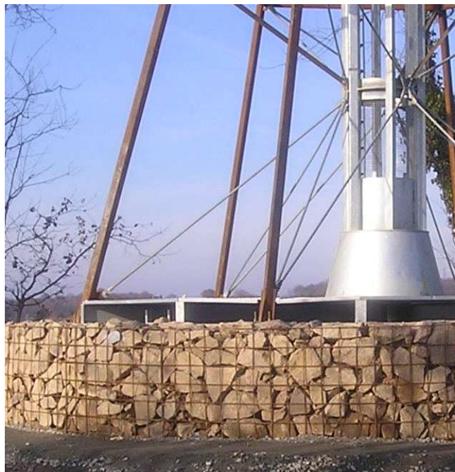
Massif – fondation creuse lestée par des gabions
