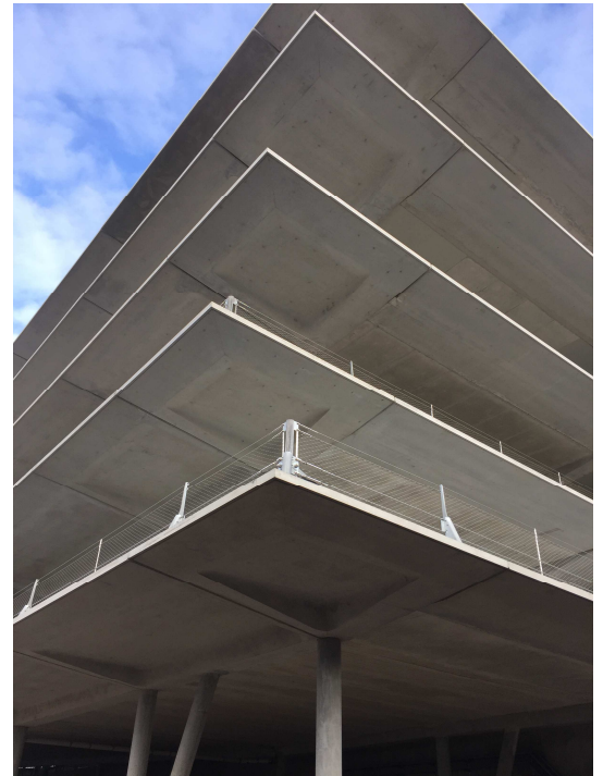
Finesse des rives béton et nervures
