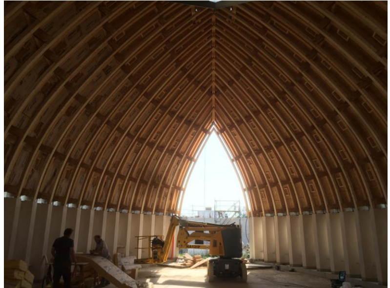
Vue de la nef centrale – arcs bois sur poteaux pierre précontrainte
