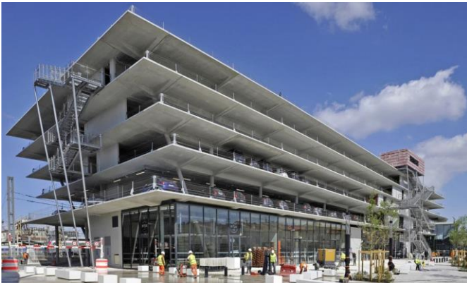
Les escaliers de secours en ossature métallique sont situés à l'extérieur.
