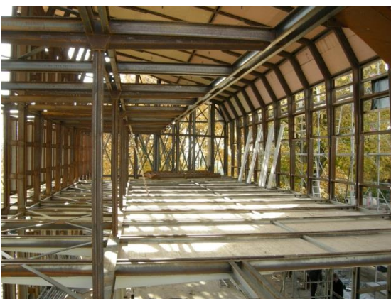
Vue du R+1 – portiques en tôle pliée Indaten planchers bois et bois-béton
