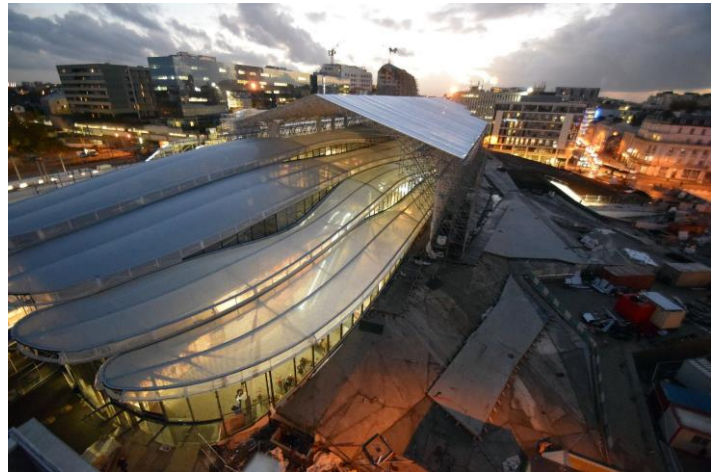
Toiture ETFE – structure porteuse acier et poteaux branches bois.
