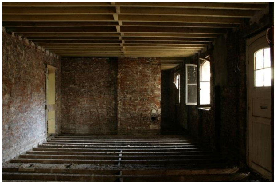
étage courant découloinné – plancher bois conservé
