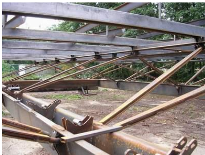
Détail d'assemblage - toile, baleines, arbalétriers et poutre Chéneau en tôle pliée
